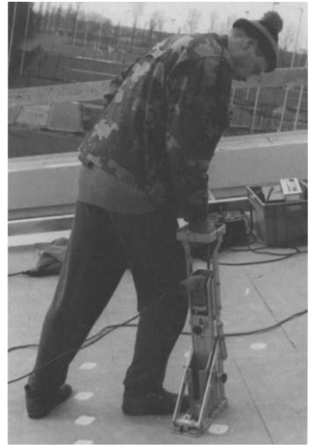
Abbildung 10: Einsatz von Bohrmaschinen durch Dachdecker mit herkömmlichem (links) und optimierten System (rechts) zur Reduzierung der Rückenbelastung 134
