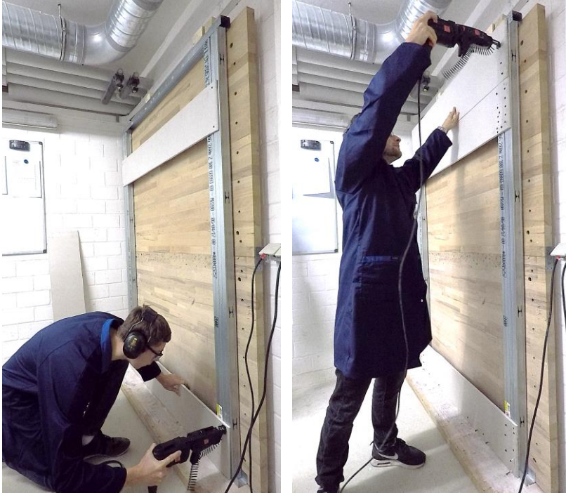
Abbildung 29 Montage von Gipskartonplatten auf CW-Profilen im Power-Tool Test-center des KIT 245
