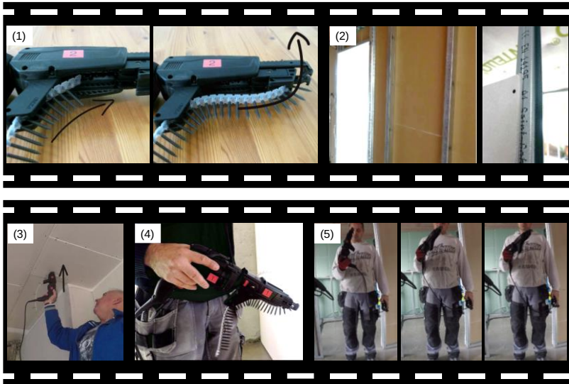
Abbildung 27: Teilszenen aus dem Basis-Trainingsvideo: (1) Einziehen der Magazinstreifen (2) Montage von Gipskartonplatten (3) Verwendung von Trockenbauschrauben (4) einnehmen der richtigen Handposition (5) Prüfung der Gewichtsverteilung 241
